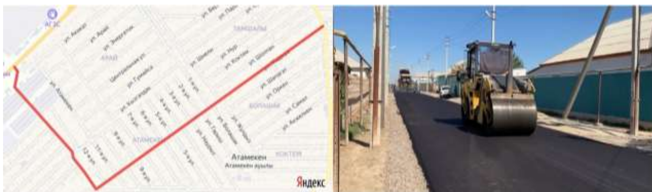
Рис. 9. Карта района строительства и укладка асфальтового покрытия на 2,6 км автодороги
