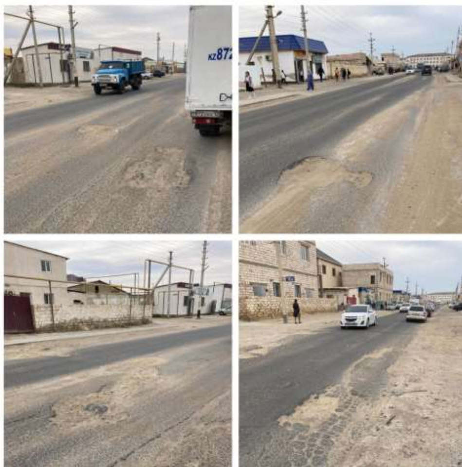
Рис. 8. Дорожные ямы по автодороге «Ару – Приозерный»
